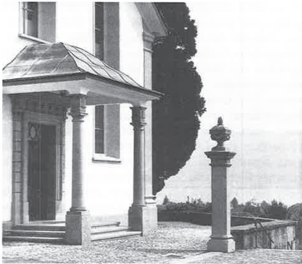
Das renovierte Hauptportal auf der Westseite.
