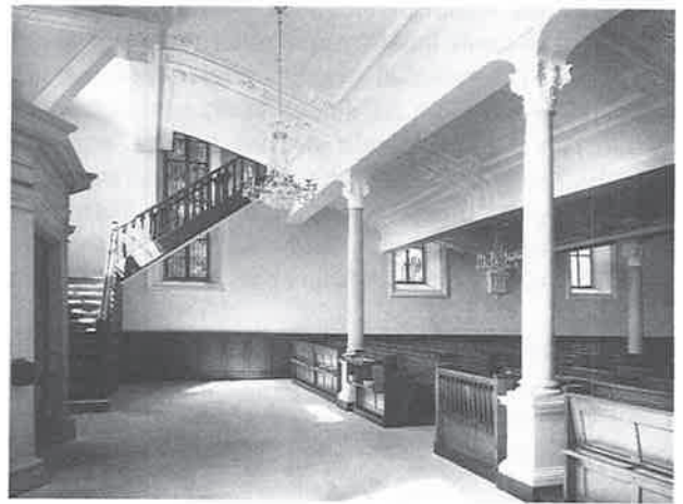
Durch die Entfernung von zwei Bankreihen konnte die Eingangspartie grosszügiger gestaltet werden.
