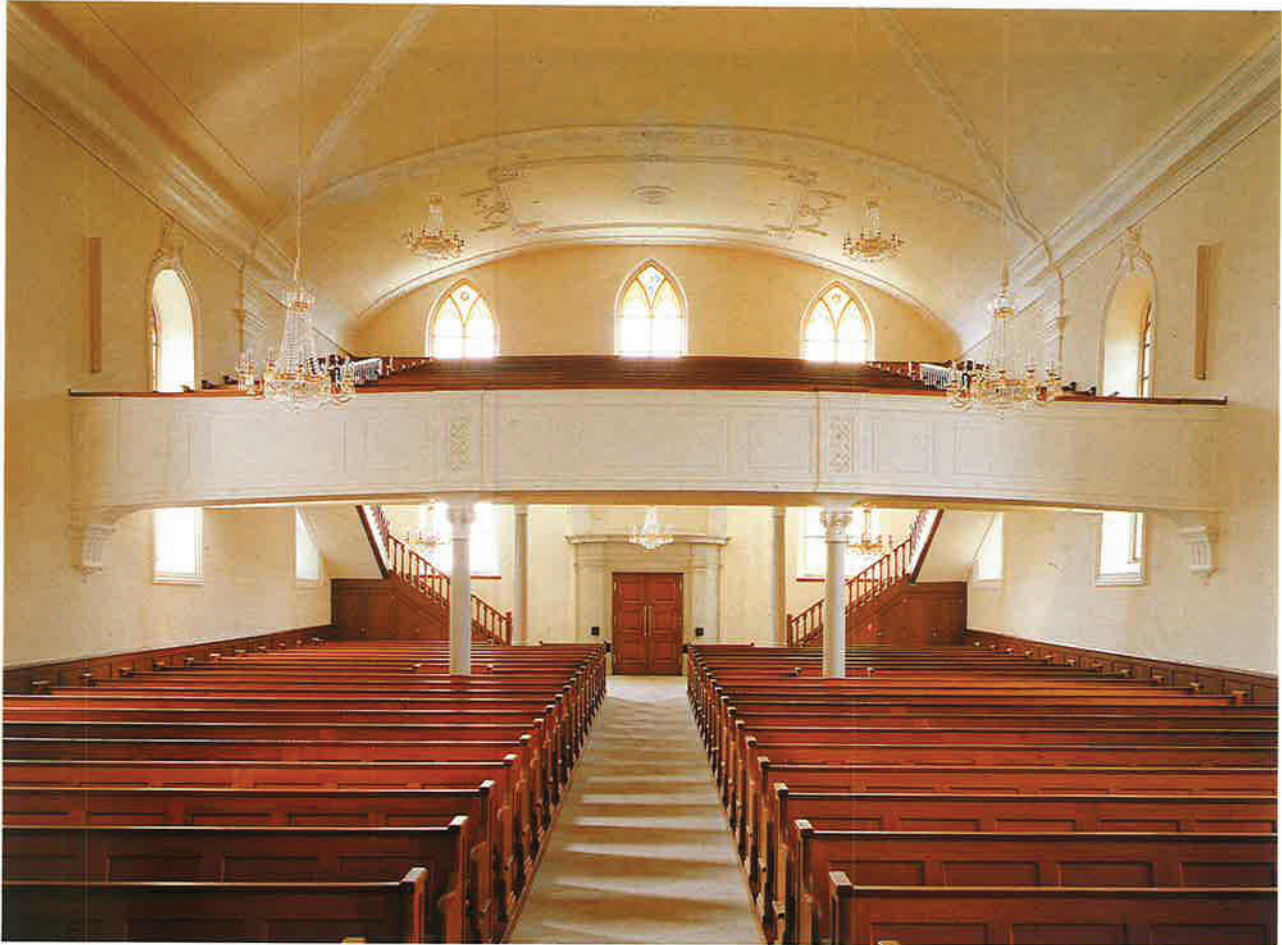
Innenansicht gegen Westen. Die Empore von 1788 wurde 1870 durch im Stil angepasste Säulen unterstützt. Die drei Westfenster – ursprünglich rundbogig – wurden 1871 in Spitzbogenform gebracht.
