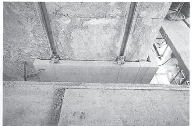
Montage der Sandstein-Ecklisenen am Turm.
