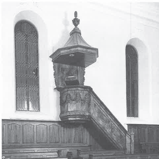
Die Kanzel verfertigte 1788 ein unbekannter Tischmacher (Schreiner). Die Verarbeitung der Nussbaumfurniere und des dekorativen Schnitzwerkes (Zopfgirlanden) zeugt von einem tüchtigen Handwerker.
