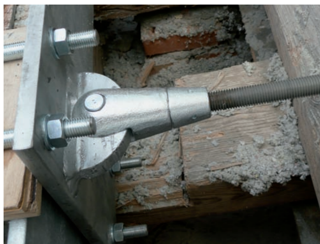
Verankerung Zugstange mit Spannplatte
