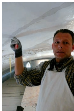
Auskratzen der Risse
