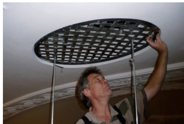
Schlosser beim Einpassen des Abluftgitters
