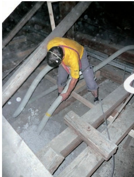
Auslocken der Gewölbedecke
