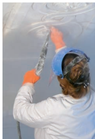
Reinigung der Stuckaturen
